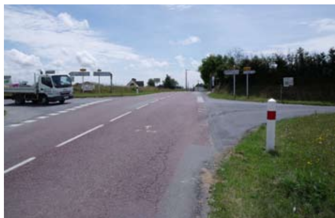
Carrefour du Frot, lieu d'accidents mortels.
