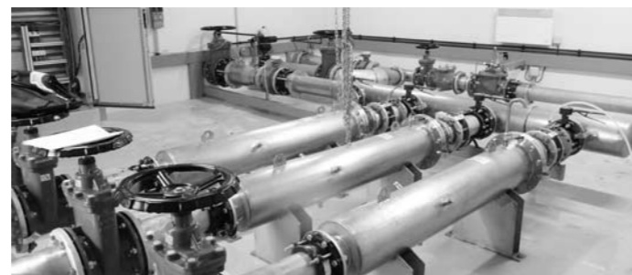
Installation de distribution d'eau potable
