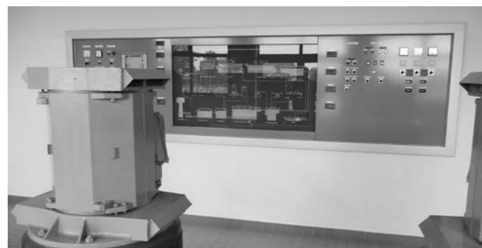
Poste de commandement de l'usine de Quetteville
