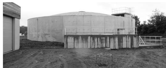
La nouvelle cuve de 2 500 m3
