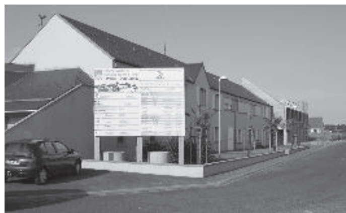
Travaux d'agrandissement de la maison de retraite
