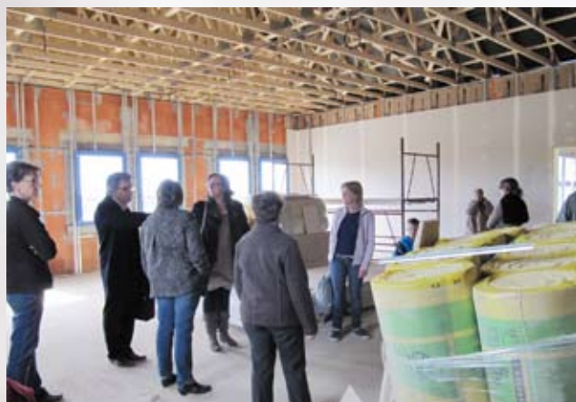
Présentation du chantier de l'école, le 27 avril.
