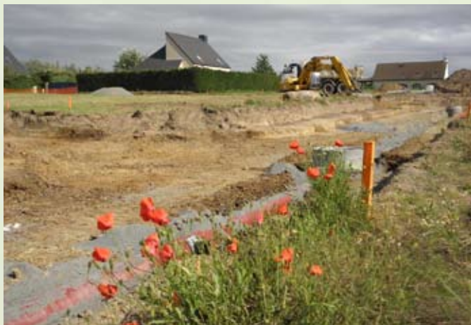
Juin 2011 : le chantier débute par le déplacement de la voirie.
